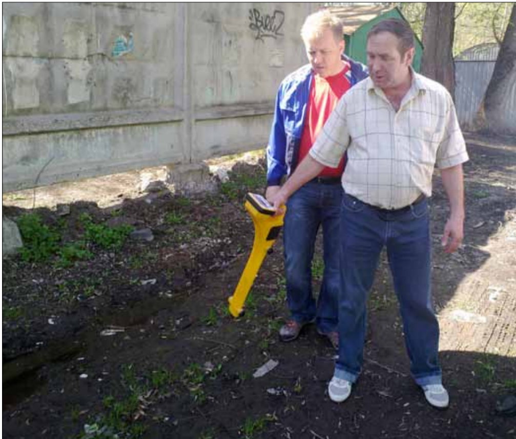
Тестовое испытание трассопоискового оборудования
